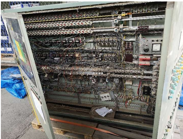
Bild: demontierte Hauptverteilung
