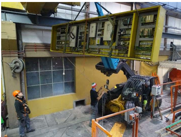
Rückbau Schaltschrank mit Manitu
