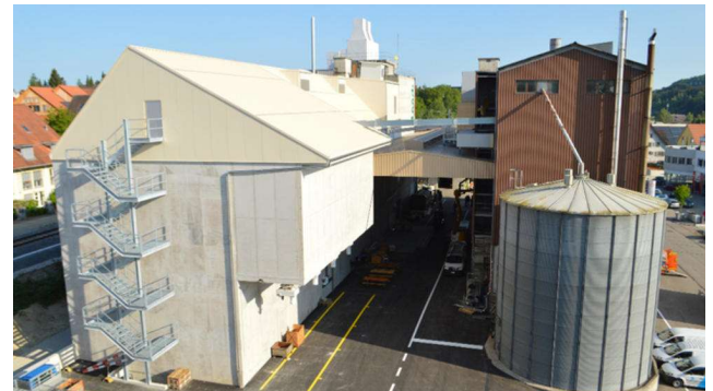
Bild (v.l.n.r): Silo 2 & Silo 1 / 104
