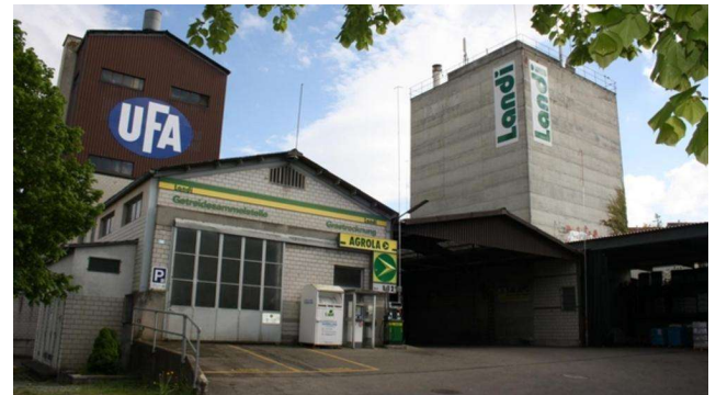
Bild (v.l.n.r): Silo 1 & Betonsilo
