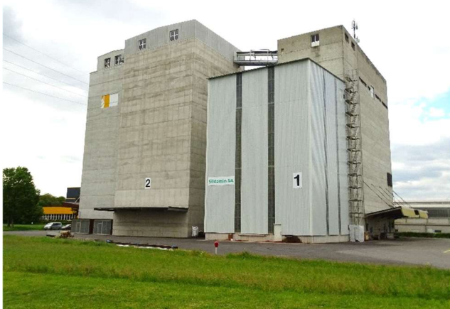
GCF, Bild (v.l.n.r): Silo 2, Silo 17 & Silo 1
