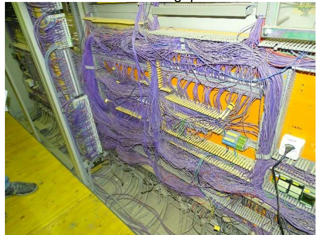
Vor dem Umbau
