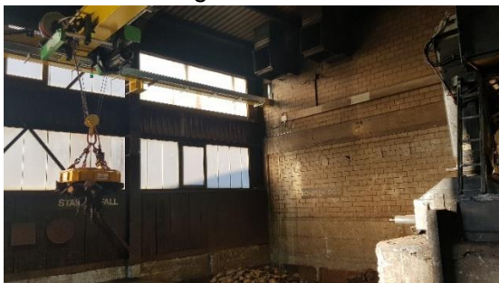
Kran mit Magneten während dem Betrieb
