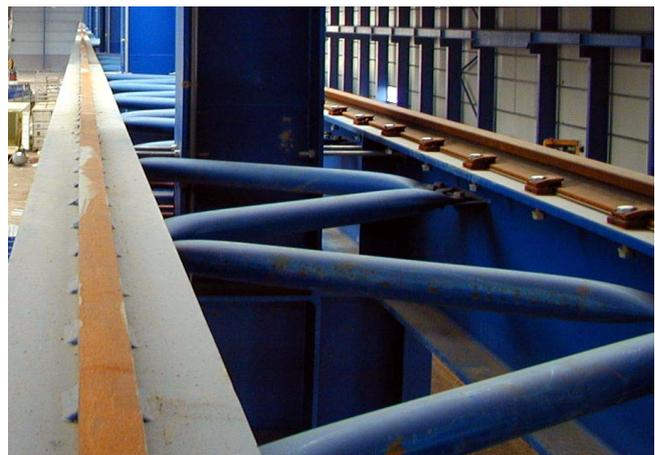
Abb. 9: Oben: Kranbahnträger mit Horizontalverband; Unten: Verband aus benachbarten Kranbahnen (Foto: Atlas Ward GmbH)
