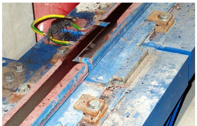
Abb. 16: Schrägstoß und Stufenstoß bei A-Schienen
