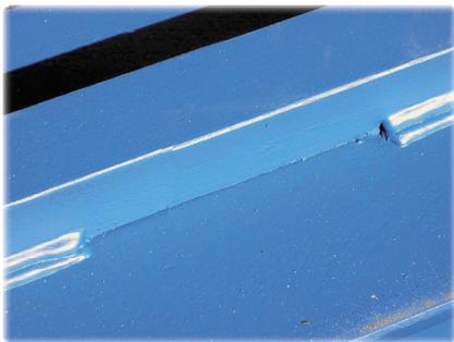
Abb. 12: Abschnittsweise angeschweißte Flachstahlschiene
